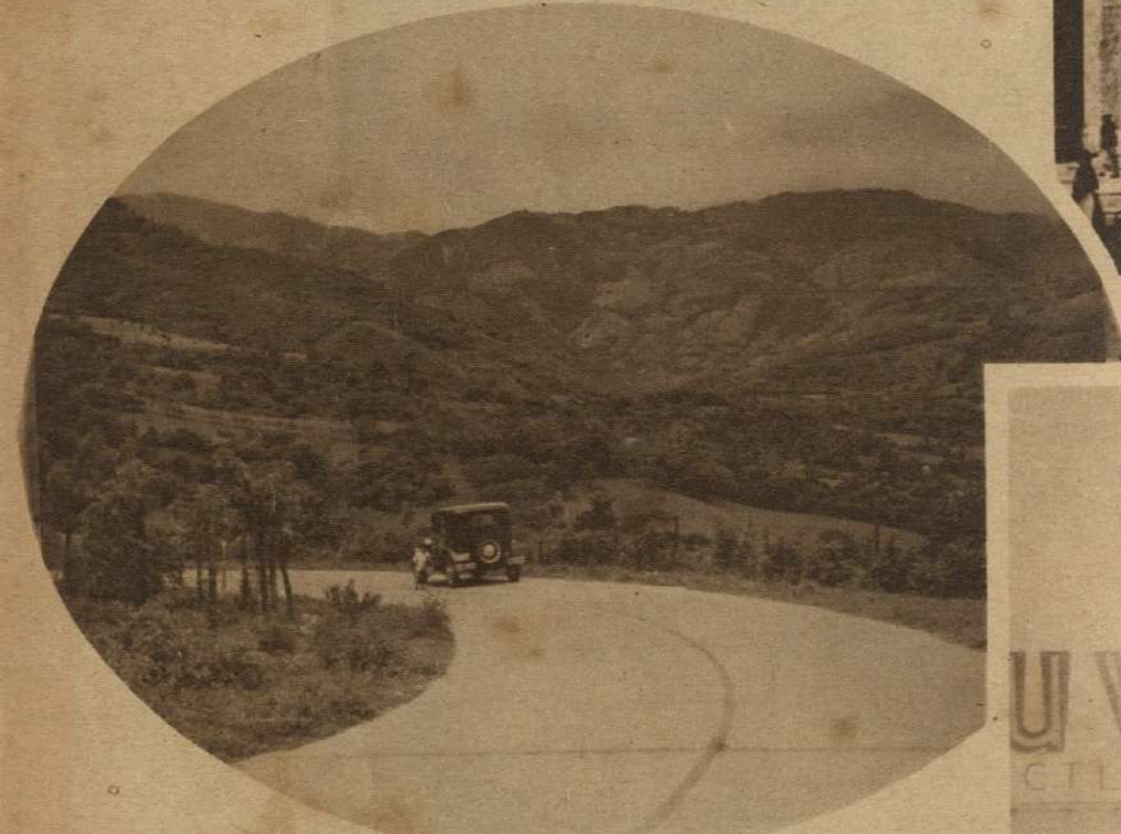
La carretera que una a San José con Santa Ana, uno de cuyos tramos se ve en esta fotografía, forma parte de la red de caminos modernos que se está construyendo en Costa Rica.
