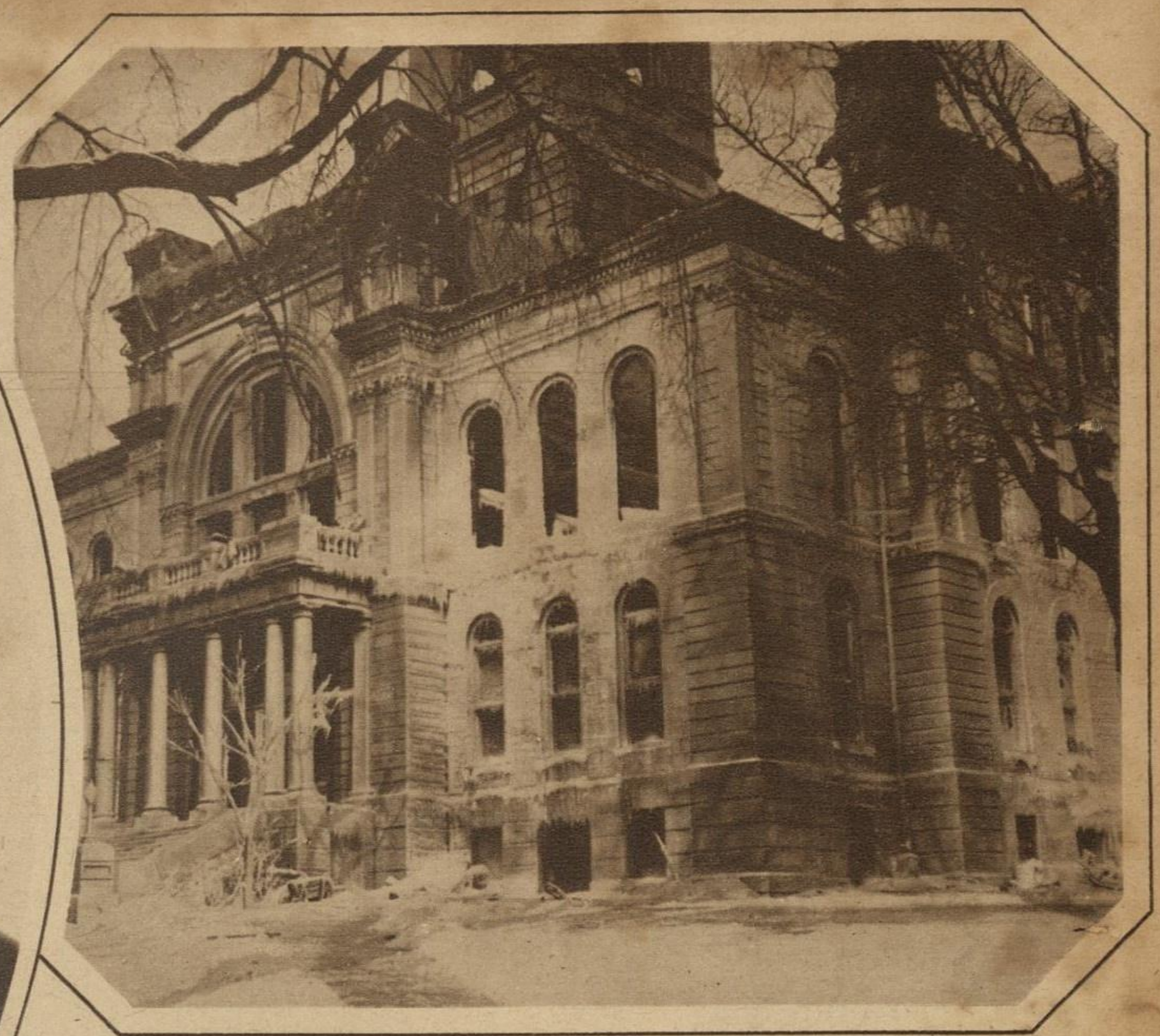
UN VORAZ INCENDIO DESTRUYO el Palacio de Justicia de Valparaíso, Indiana, Estados Unidos. El intenso frío impidió la intervención de los bomberos quedando el edificio completamente arrasado interiormente.
