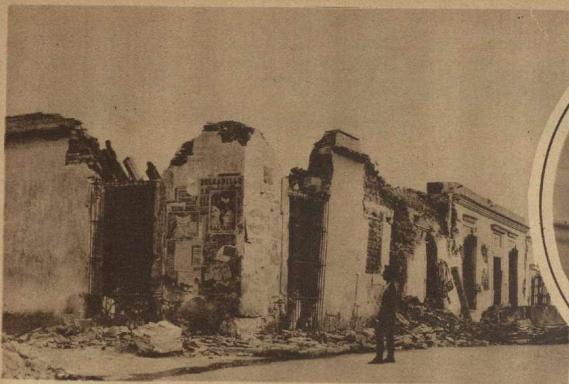
UN TEMBLOR DEJO EN RUINAS a la ciudad de Oaxaca, Capital del estado del mismo nombre, en México. La fotografía de arriba muestra cómo quedó la ciudad. A la derecha vemos a algunos refugiados, viviendo bajo techos improvisados.
