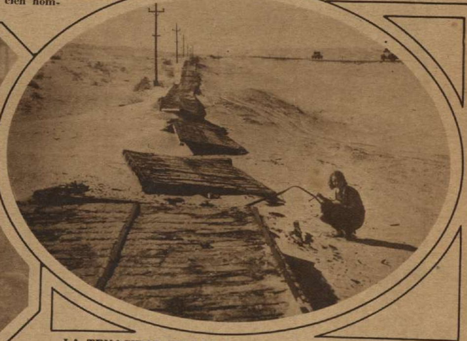
LA TENACIDAD DE LOS CONQUISTADORES DEL SIGLO XIX, puede todavía apreciarse al contemplar estos restos de un camino de tablas, lanzado a través del desierto de Nuevo México, por distancia de setecientos kilómetros. Servía para el paso de las diligencias y caravanas de los buscadores de oro. A la derecha se ve el nuevo camino para automóviles.
