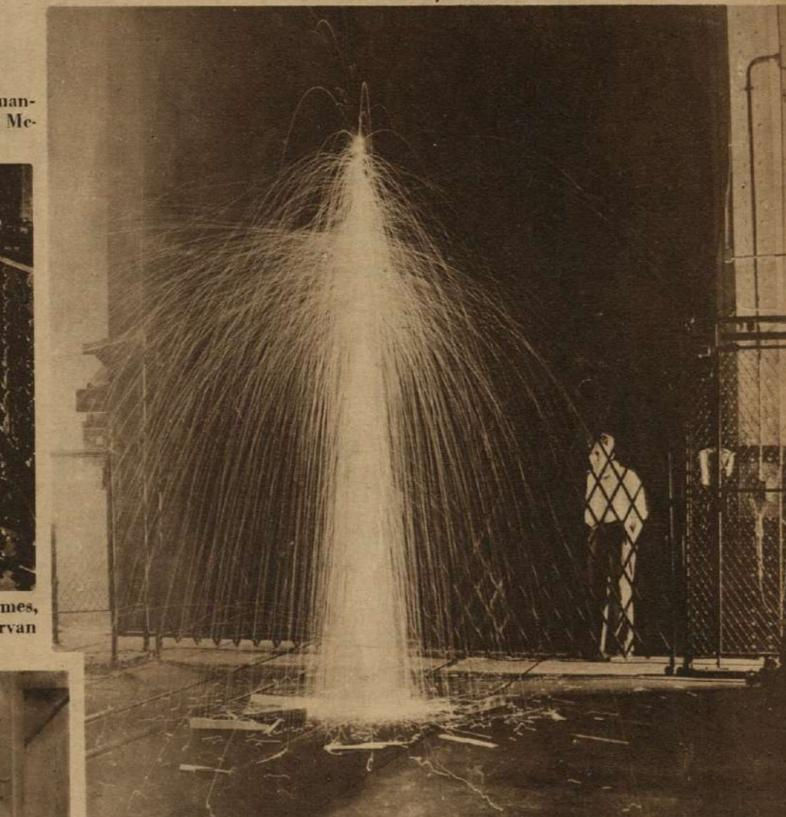
He aquí lo que ocurre cuando un rayo artificial choca contra un alambre de resistencia: se produce una cascada de metal en fusión que alcanza considerable altura.
