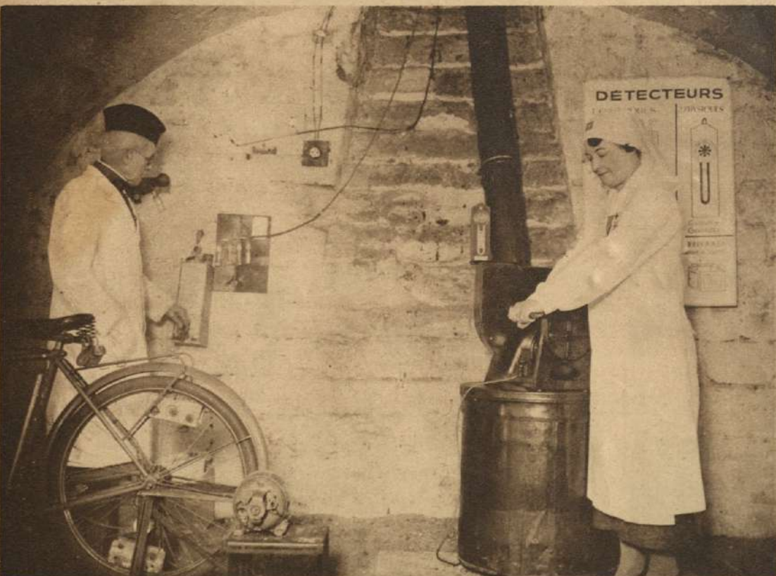
Interior de un refugio contra los gases. El médico estudia la presión del aire y la enfermera maneja el aparato purificador. La bicicleta hace funcionar un motor.
