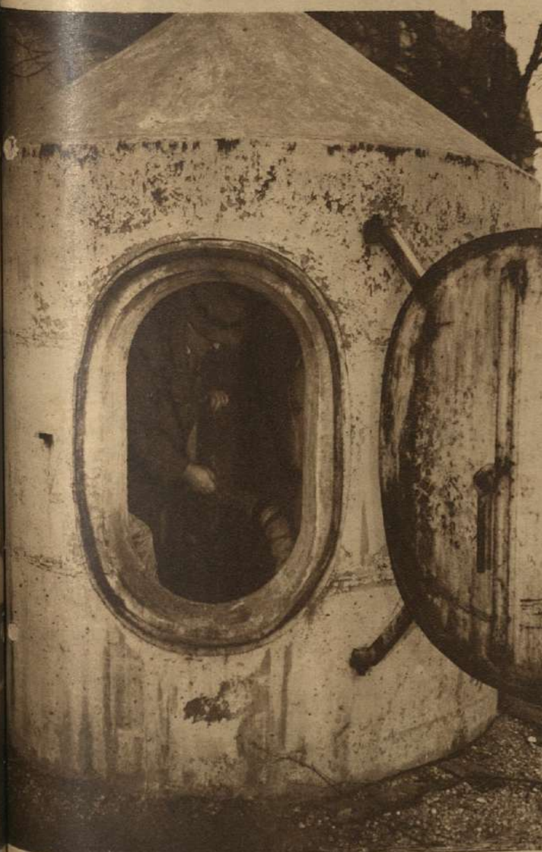
Se accede a un refugio contra bombas y gases, capaz de dar albergue a 4 personas. Estos refugios se hacen de hormigón armado y contienen tanques de oxígeno.
