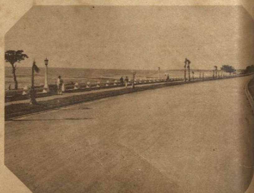
Moderna Avenida George Washington, denominada hasta
