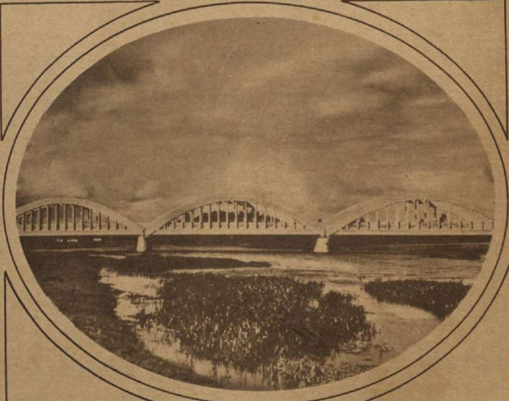
EL PUENTE CONSTRUIDO POR POLONIA, sobre el río Byura, es una innovación en el mundo de la ingeniería, pues sus partes están soldadas por un procedimiento especial, en vez de ser riveteadas, como se acostumbra en obras de esta naturaleza.
