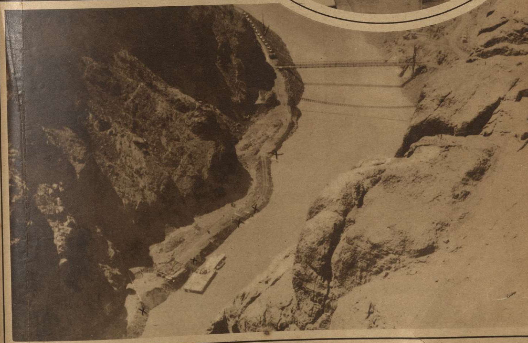
LA ENTRADA A LA PRESA HOOVER en el estado de Arizona, Estados Unidos, se vió inundada antes de su terminación, causando paralización general de los trabajos. En los sitios marcados con X se está extrayendo el agua para poder proseguir.
