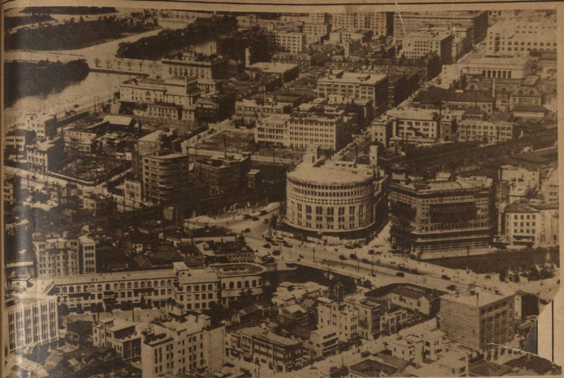
TOKIO RENACE DE SUS CENIZAS.—Vista aérea del centro comercial de la capital del Imperio del Sol Naciente, en la cual se ven los edificios modernos construidos después del desastre de hace pocos años.
