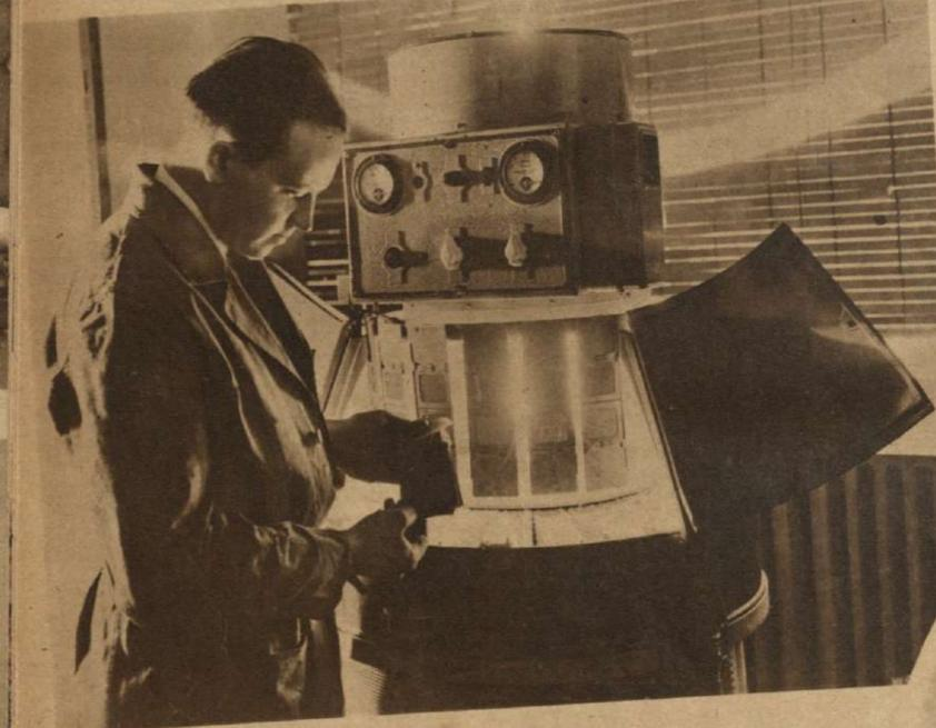
El aparato que aquí se ve ha recibido el nombre de Fadeometer y sirve para probar la resistencia o firmeza de los colores aplicados a cualquier material.
