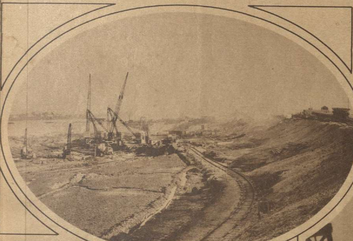
EL PUERTO DE SOUTHAMPTON en Inglaterra, ha emprendido obras de importancia, ampliando los diques secos para dar cabida a los trasatlánticos modernos.
