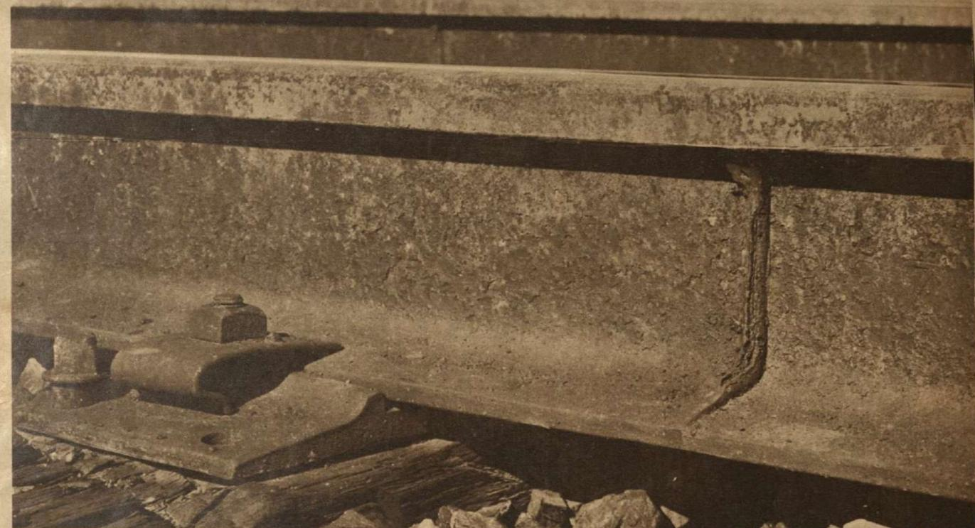
Usando rieles de 12 metros, el tráfico produce desgaste en las uniones y eso ocasiona a su vez costosos trabajos de reconstrucción, que se eliminan considerablemente con los rieles soldados.
