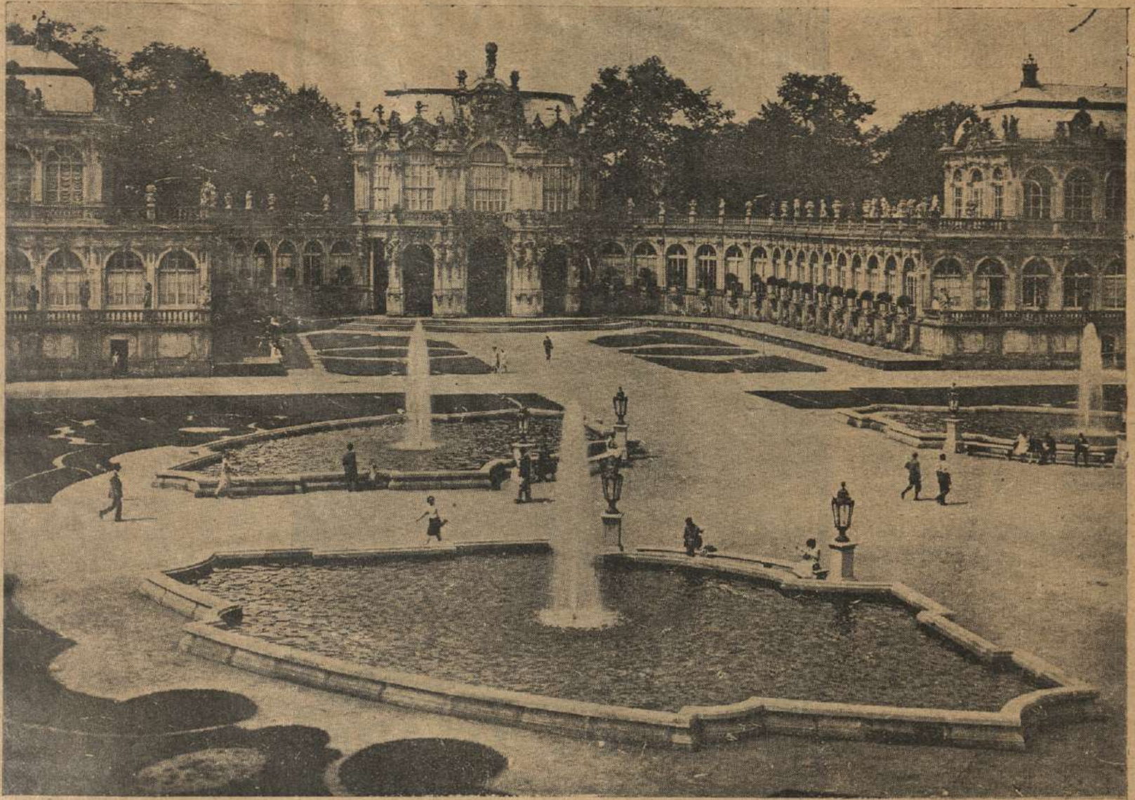
Una vista parcial del famoso ZWINGER, de Dresde, que ha sido recientemente reconstruido.
