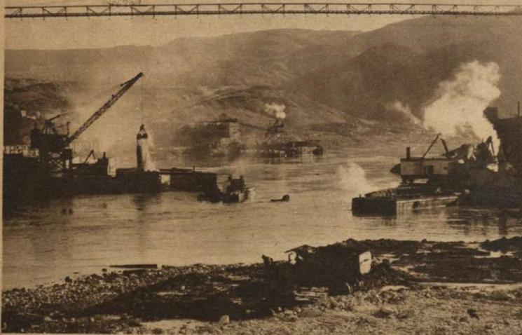
Al completarse el dique que se ve aquí en construcción, quedará en seco la parte central del río para la erección de los contrafuertes.
