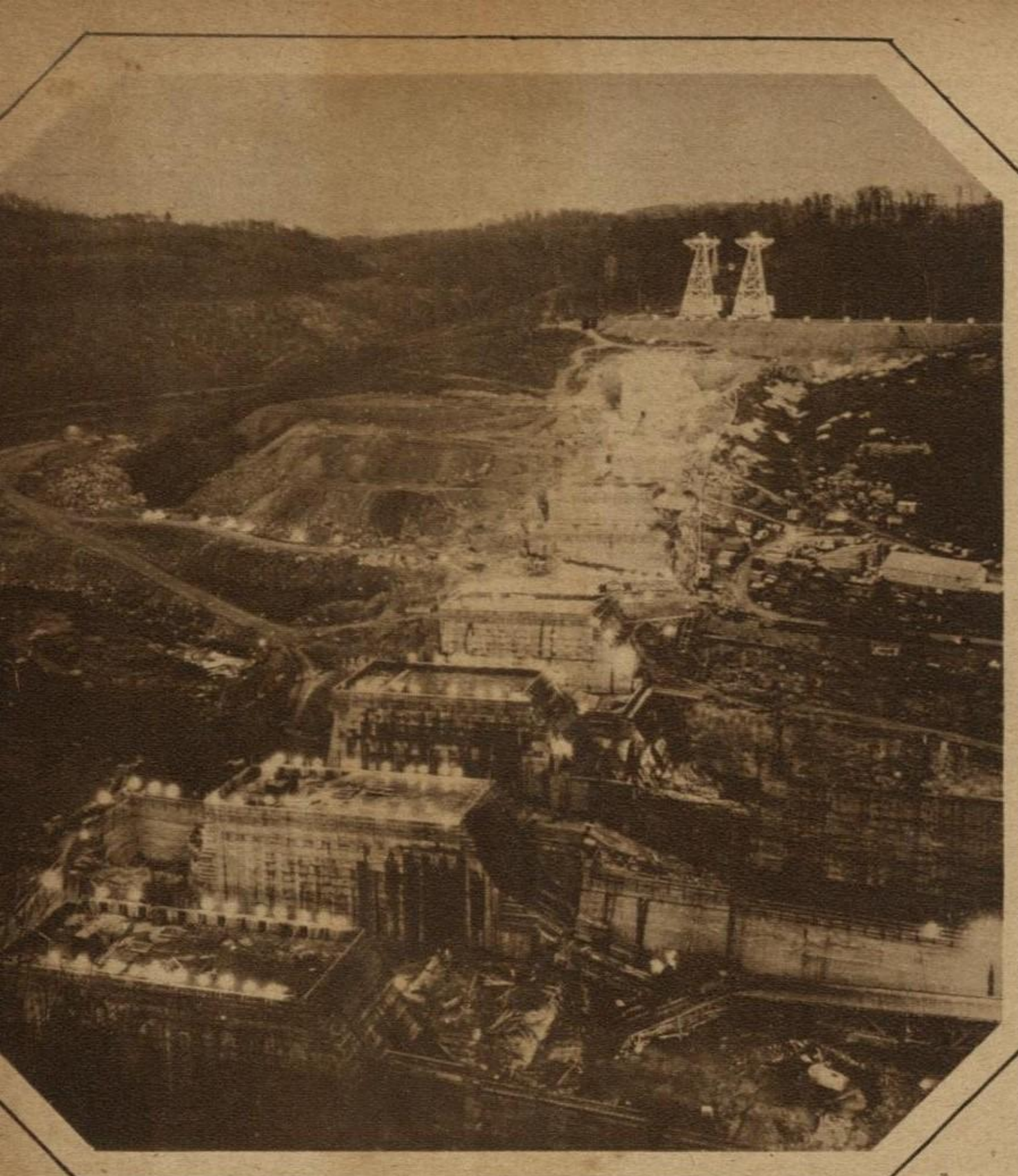
ESTA GENERAL DE LA PRESA NORRIS, en Tennessee, Estados Unidos. Por medio de un dique que tendrá setecientos metros de ancho, se formará un lago artificial de ciento cincuenta kilómetros cuadrados que proporcionará energía eléctrica a una inmensa región.
