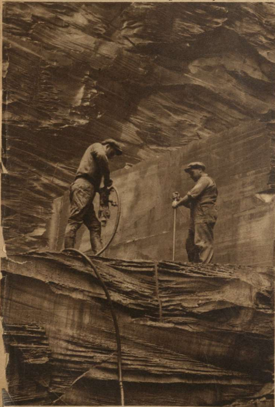
Un yacimiento de pizarra revelando el sistema empleado para arrancar grandes trozos de la cantera original.
