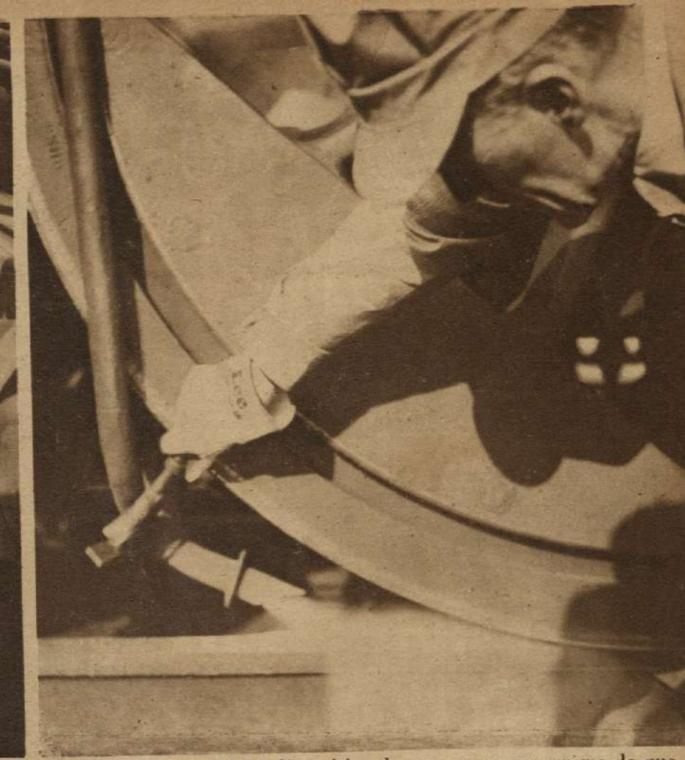
Ahora está revisando el dispositivo de arena para asegurarse de que ca un chorro uniforme de arena frente a las ruedas motrices, para que no resbalen al aplicar los frenos.
