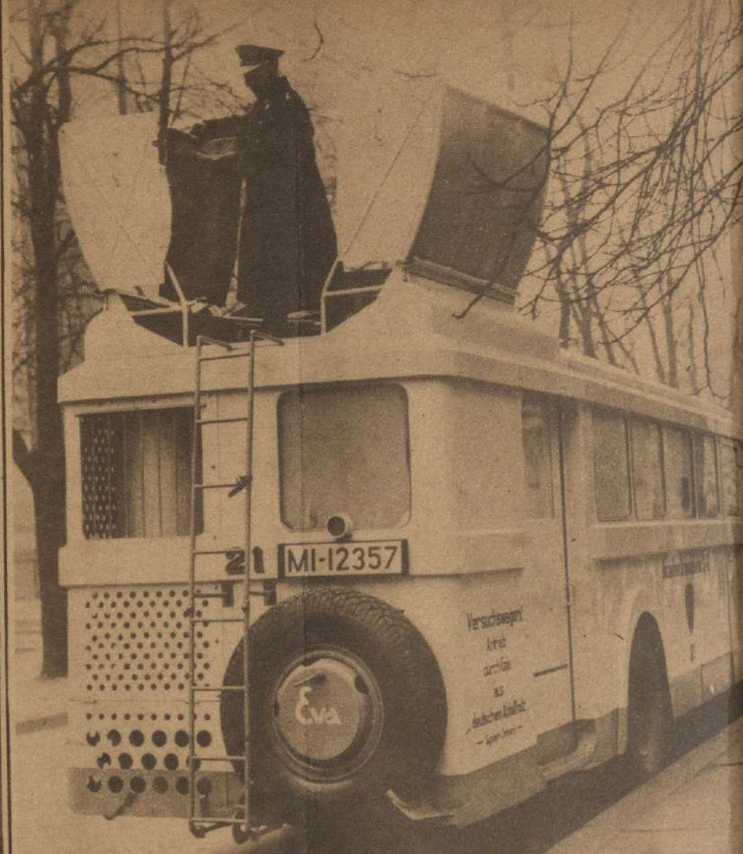
OMNIBUS MOVIDO POR GAS DE MADERA: una compañía de transportes en Alemania puso en servicio este omnibus, que emplea como combustible gas extraído de la madera y que resulta muy económico.
