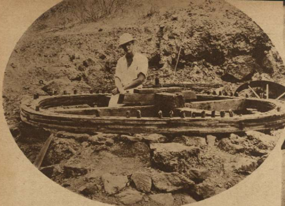
VESTIGIOS ESPAÑOLES EN CALIFORNIA.—Al excavar se la cordillera por donde ha de pasar el nuevo acueducto para Los Angeles, se encontró este vetusto molino triturador de piedras auríferas, cuyo origen se ignora.
