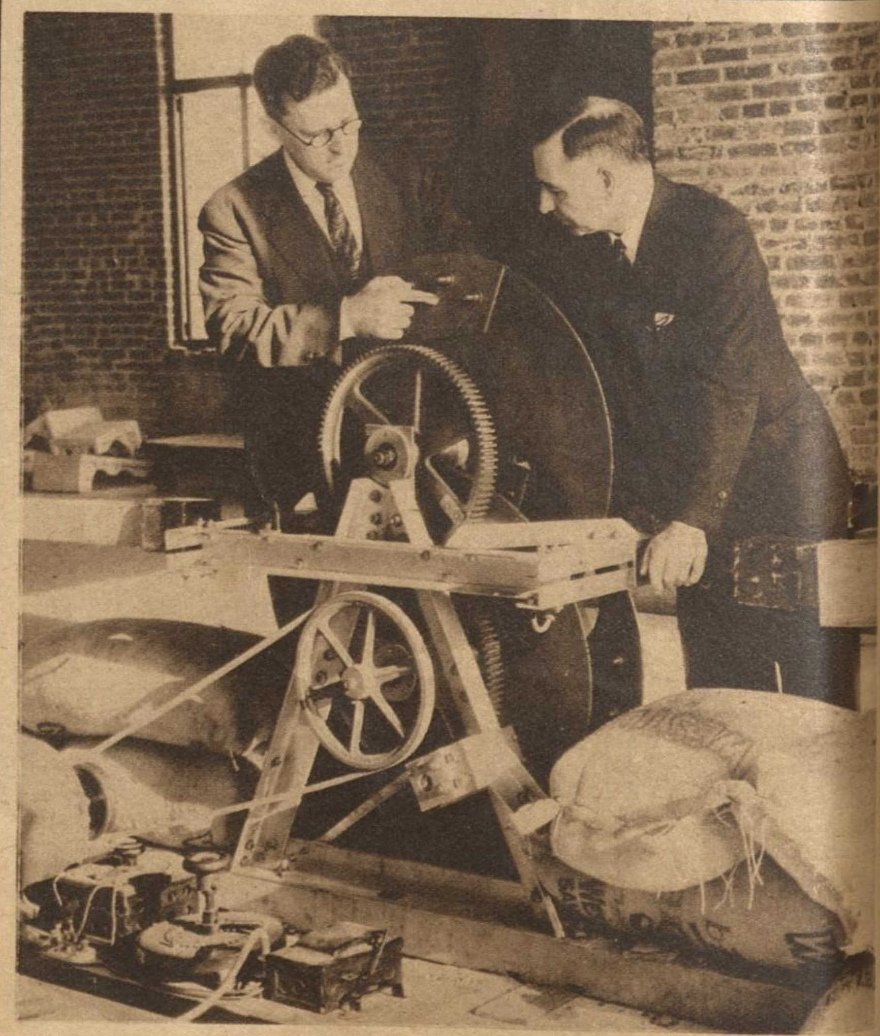
TERREMOTOS SOBRE MEDIDA.—Este curioso invento que hace vibrar los edificios más elevados imprimiéndoles movimientos análogos a los causados por los terremotos, fué ensayado en la municipalidad de Los Angeles, California, causando gran alarma a los ocupantes
